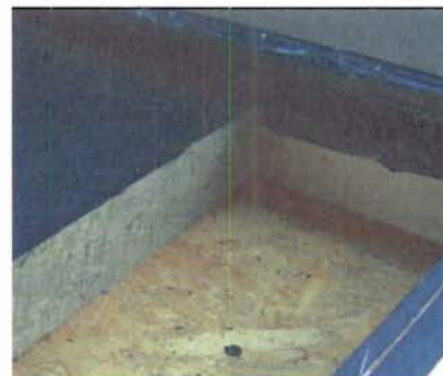
Ansicht der Isolierung view of the insulation
